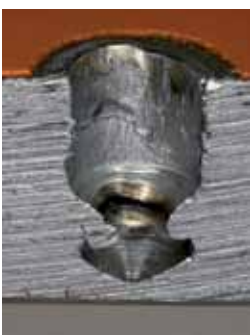
Matériau de base en acier après 7 ans d'exposition à l'eau de mer et arrachement du goujon X-BT. Ce trou semble propre et aucune trace de corrosion n'est visible.
