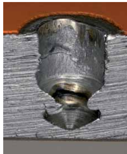
Matériau de base en acier après 7 ans d'exposition à l'eau de mer et arrachement du goujon X-BT. Ce trou semble propre et aucune trace de corrosion n'est visible.
